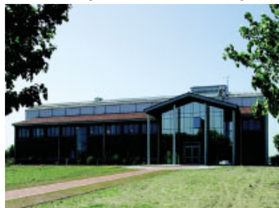
Der Albert-Einstein-Bau, das neue Optik-Gebäude der PTB.
