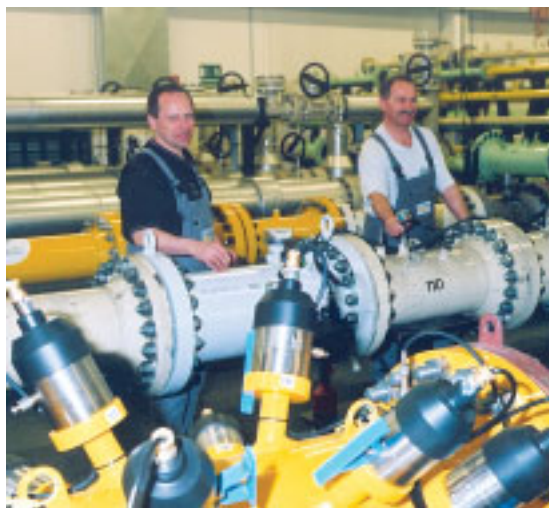
Ein Teil des pigsar-Teams während der Telekalibrierung. Im Vordergrund der kalibrierte Gaszähler.
