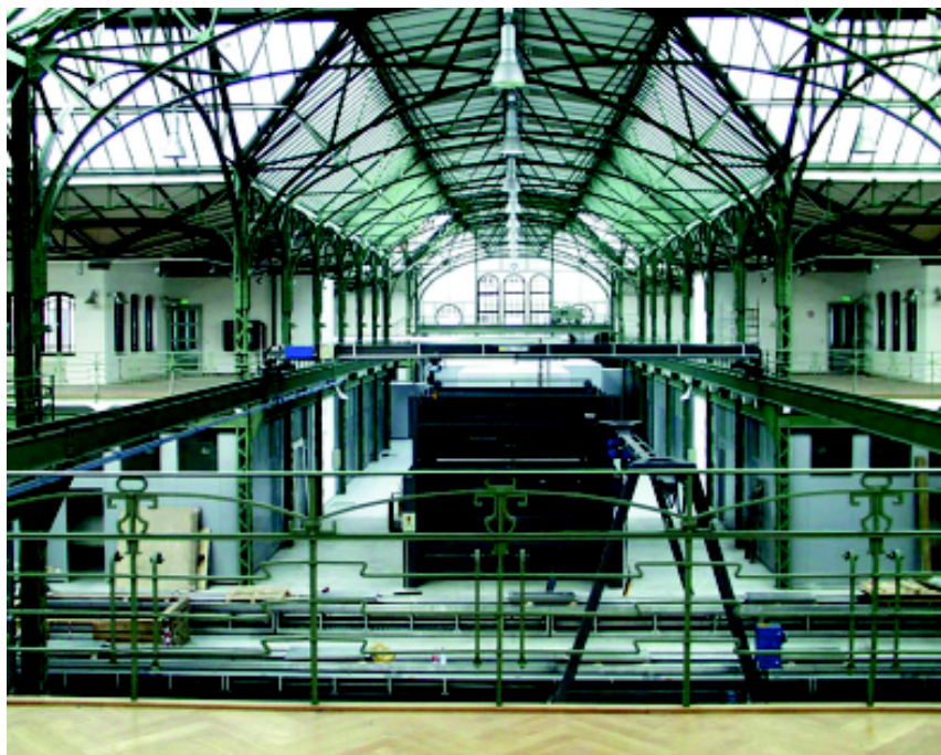
Der Blick in die Halle des Hermann-von-Helmholtz-Baus der PTB in Berlin-Charlottenburg zeigt die filigrane Trägerkonstruktion des ehemaligen Deutschen Arbeitsschutz-Museums.
