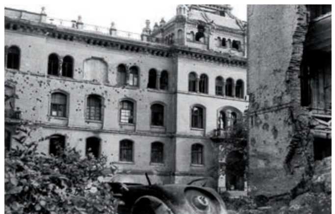
Der Krieg hat große Schäden am Hauptgebäude der PTR in Berlin hinterlassen.
