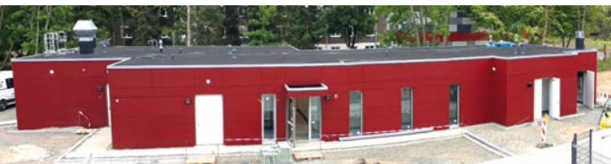
Das neue Laborgebäude der PTB für die Baumusterprüfung von Kfz-Abgasmessgeräten
