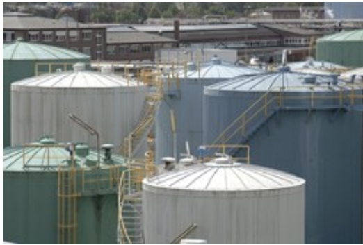
Abbildung 1 Lagertanks können mehr als 50 Millionen Liter fassen. Das über den Füllstand ermittelte Flüssigkeitsvolumen ist jedoch temperaturabhängig.
