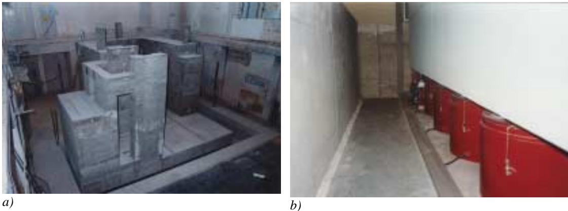
Bild 8 a) Waagenfundament im Rohbauzustand b) pneumatische Schwingungsisolatoren unter dem Waagenfundament
